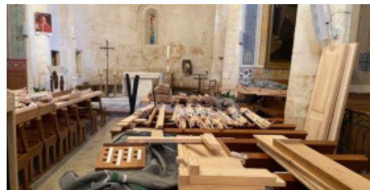
Avant montage : toute l'Eglise est occupée par les pièces de l'orgue.
