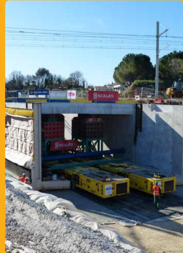
Dans le cadre des travaux de suppression du passage à niveau n°33, une phase importante du chantier a été mise en oeuvre le 1<sup>er</sup> avril dernier. Il s'agit de la mise en place du pont-rail qui permettra à la route de passer sous la voie ferrée.
