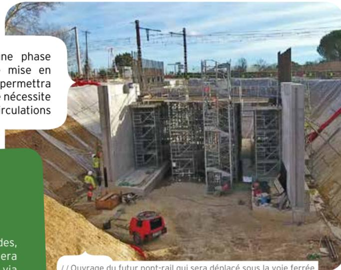
// Ouvrage du futur pont-rail qui sera déplacé sous la voie ferrée
